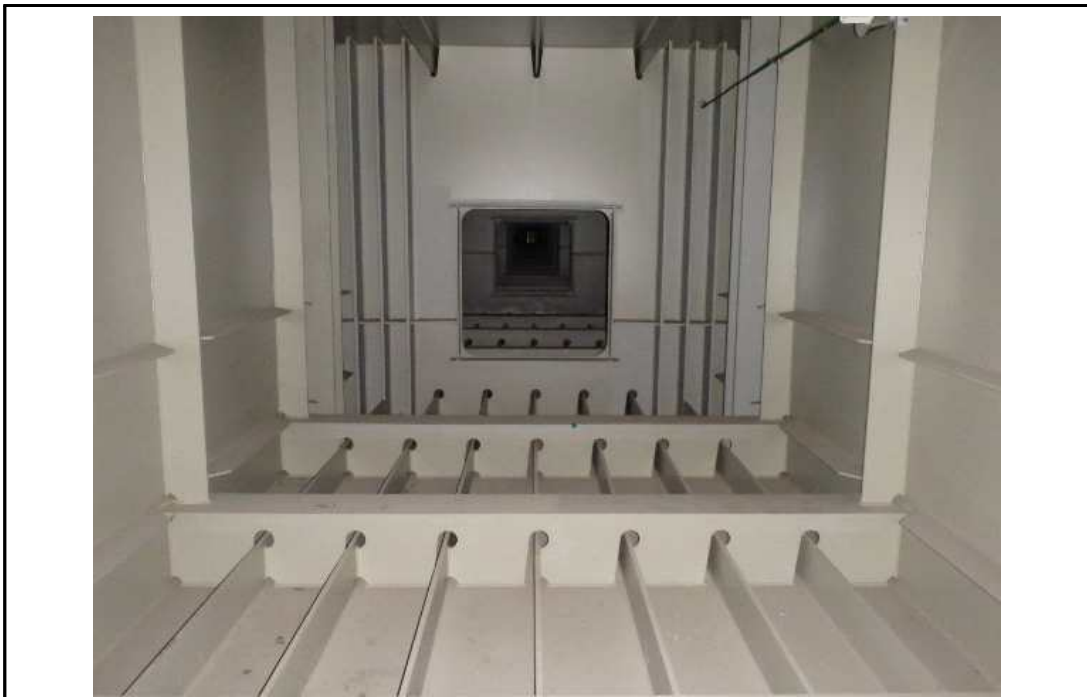
Steel Box Girder 내부 전경
