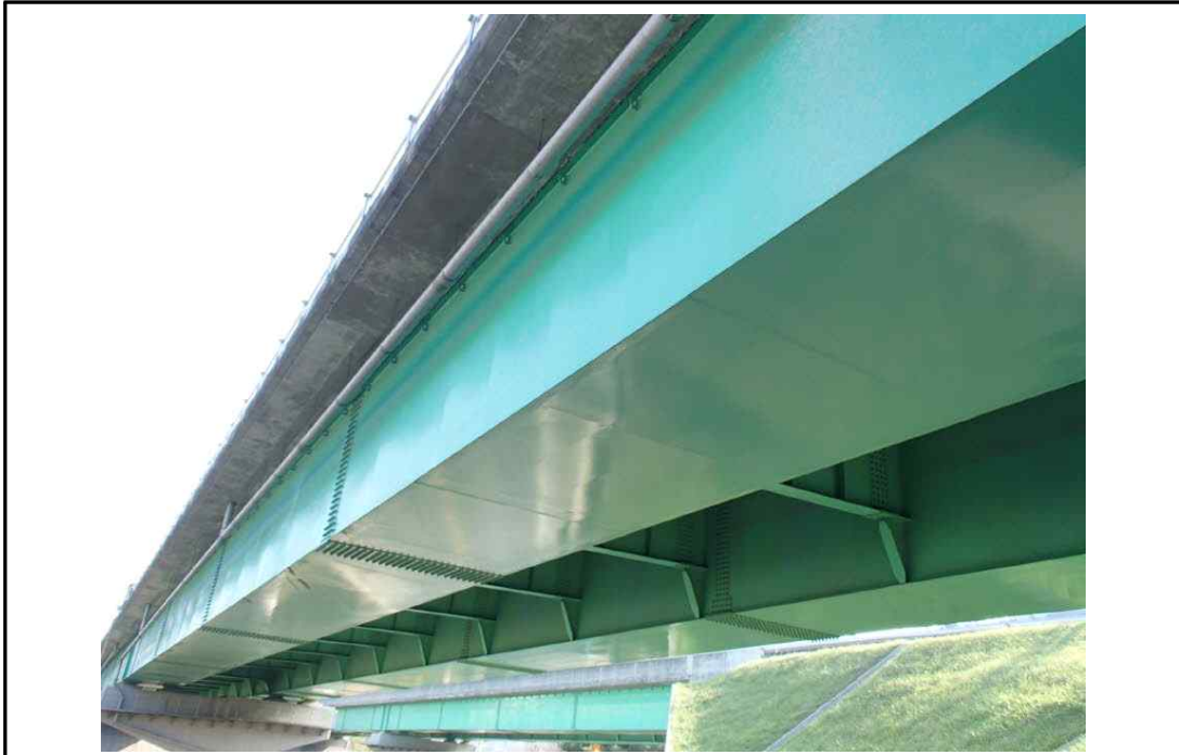
Steel Box Girder 외부 전경
